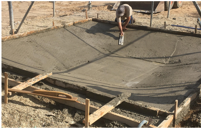
Pouring the Cement Liner
